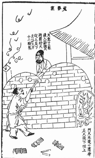
図2 景德鎮の饅頭形窯 (『天工開物』より)
